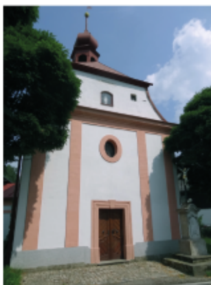
kaplica Trójcy Przenajświętszej w Svorze
